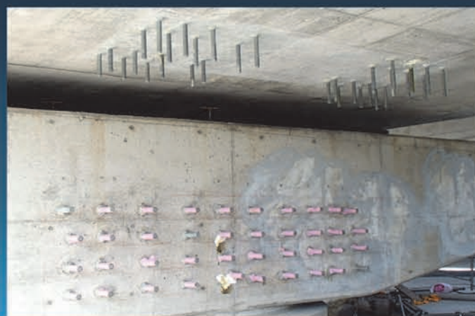
削孔穴中心の計測
