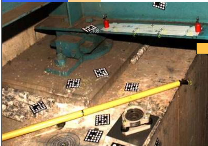
ボルト孔位置関係を計測
