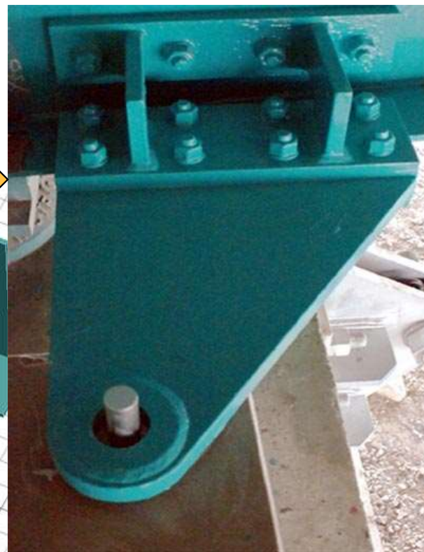
製作した部材を取付
